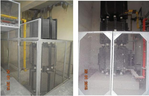
**Фиг.3.** Общ вид на токоограничаващи реактори Ср.Н., използвани във вътрешнозаводска подстанция
